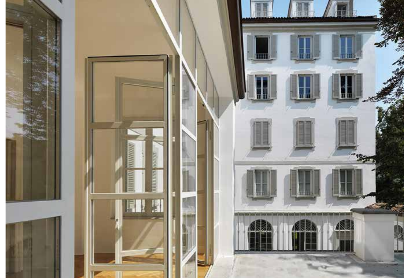
L'intonaco bianco e gli ampi serramenti in vetro delle facciate esterne che caratterizzano la ristrutturazione dell'edificio
